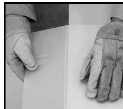
Figura 4. Separação da parte riscada.
